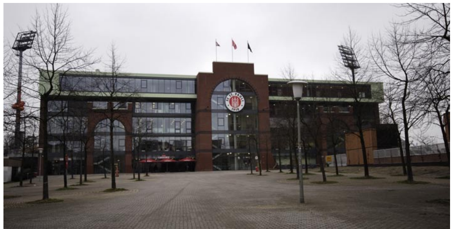
Die neue Tribüne vermittelt bereits einen Eindruck vom Gesamtbild des fertigen Umbaus
