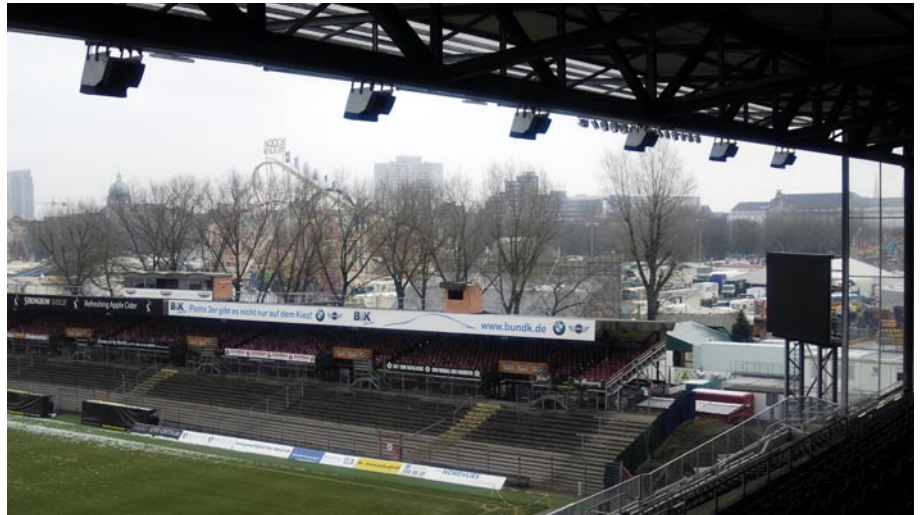
Die Gegentribüne: Mit Stahlrohr-„Oberrang“ und Überdachung ausgestattet Bild: Scanvest Deutschland GmbH
