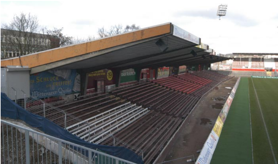
Wann die alte Haupttribüne ersetzt wird, steht in den Sternen
